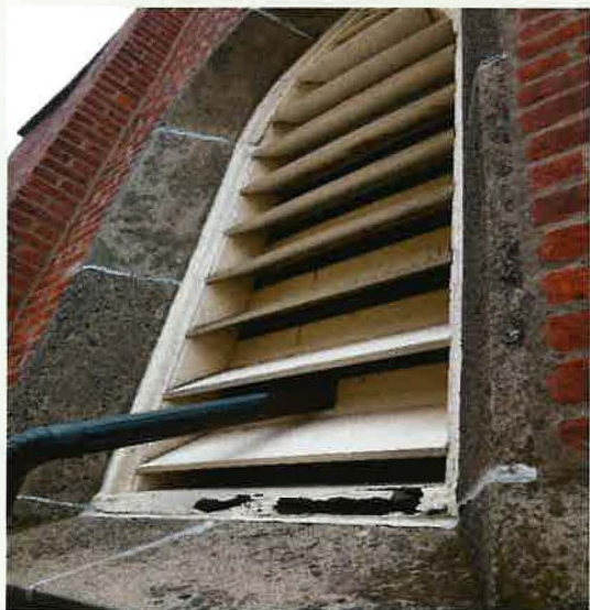
TORONY ZSALUGÁTER JAVÍTÁSA
